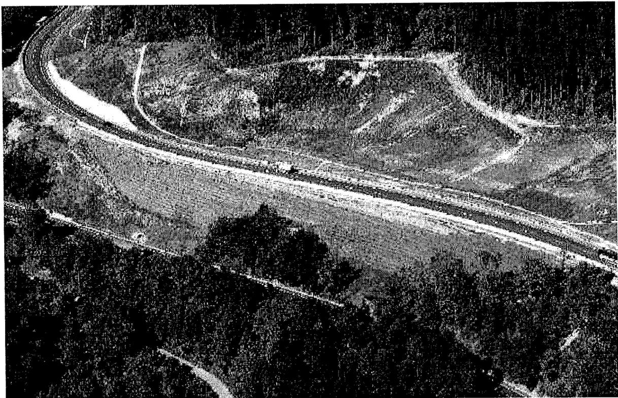
Abb. 21: Gesamtansicht des geogitterbewehrten Autobahndamms bei Etxeerate kurz nach Inbetriebnahme
