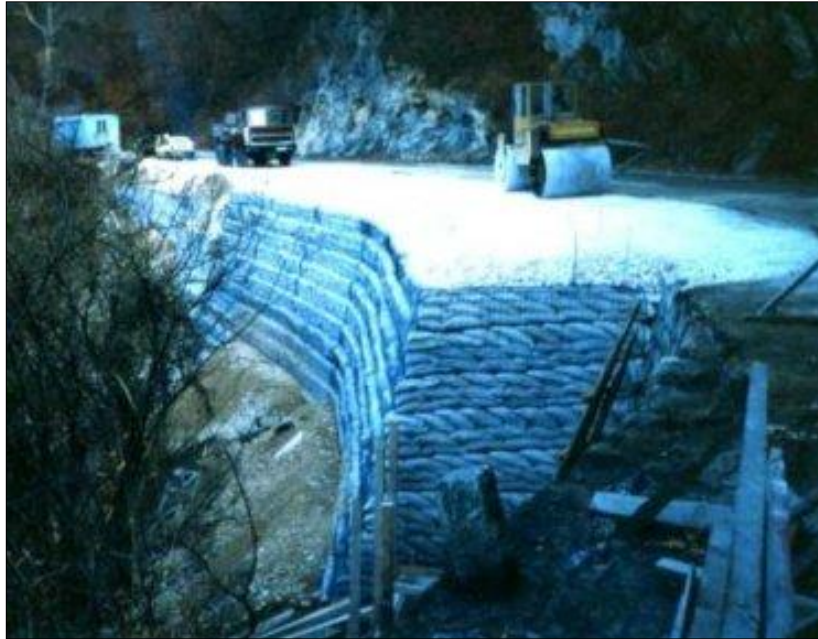
Figure 3: Projet “Jugovsko Hanche”- Fin de la construction du mur de soutènement avant la mise en œuvre du parement minéral Muralex
