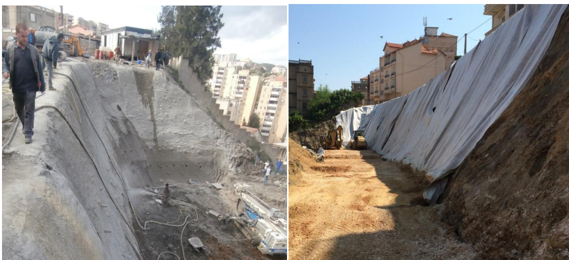
Figure 8 : Projet « Beni Malek » - Tirants d'ancrages en amont du glissement et béton projeté (à gauche) et géocomposite de drainage (à droite)
