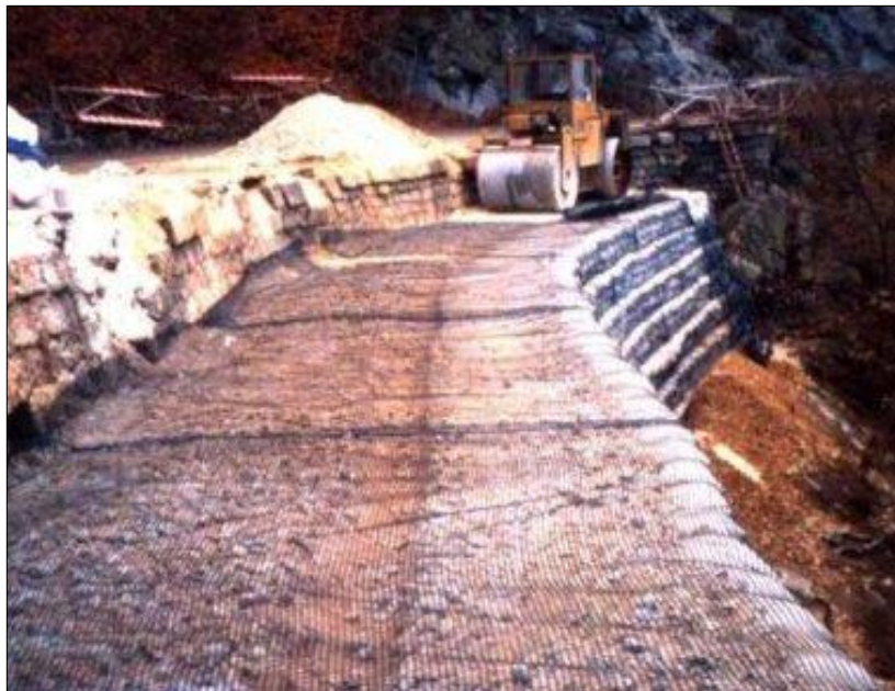
Figure 2: Projet “Jugovsko Hanche”- Construction du mur de soutènement renforcé par des géogrilles adossé au mur en maçonnerie existant.
