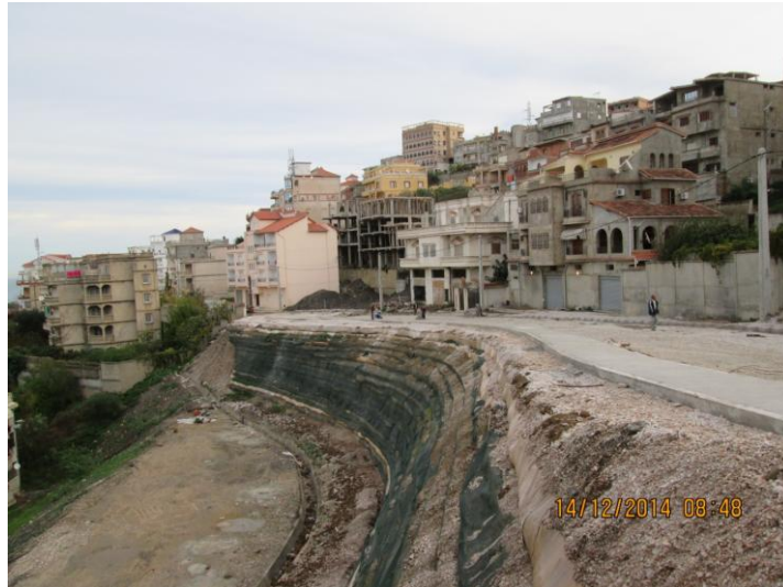
Figure 9 : Vue sur le massif de soutènement renforcé par des géosynthétiques
