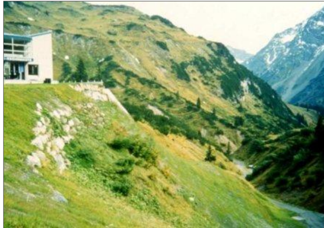
Figure 7 : Projet « Steinmader Wand » -Parfaite intégration paysagère du massif de soutènement renforcé par des géogrilles
