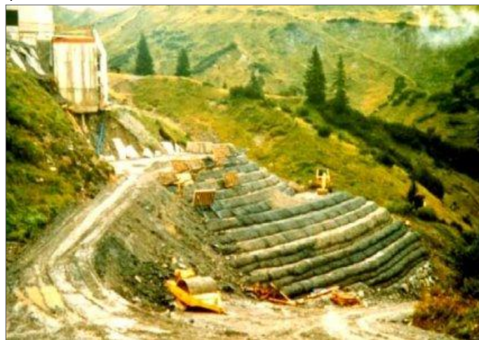
Figure 6 : Projet « Steinmader Wand » -Construction du massif de soutènement renforcé par des géogrilles
