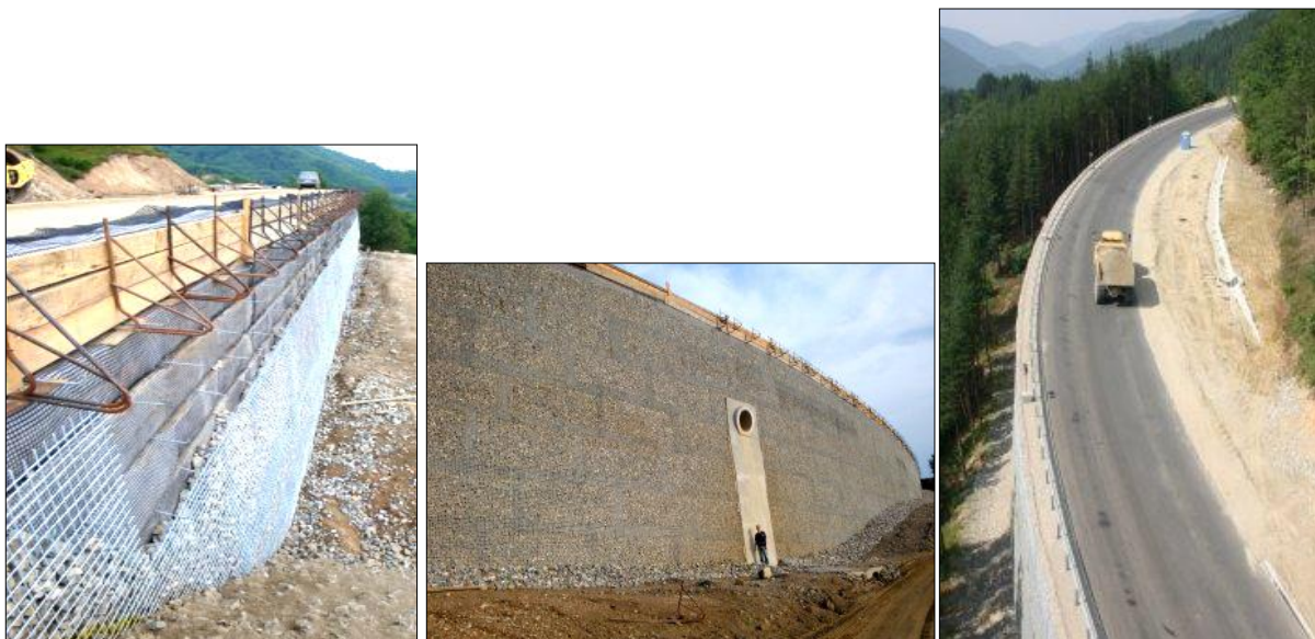
Figure 4. Projet « Route III-868 » - Mur de soutènement renforcé par des géogrilles de grande hauteur sans risberme à parement minéral Muralex®
