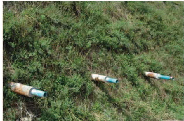
Figura 4. Micro-drenos instalados.
