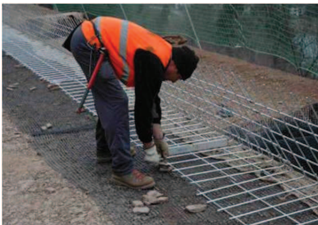
Figura 5. Execução dos moldes metálicos.
