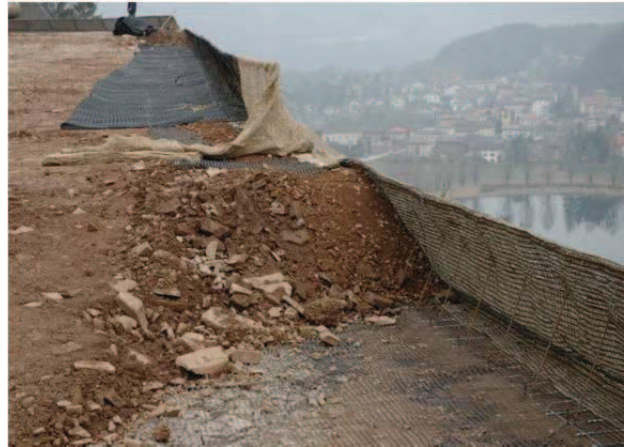
Figura 9. Execução de uma camada de solo compactado.
