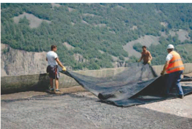
Figura 8. Instalação de geogrelha do reforço primário.
