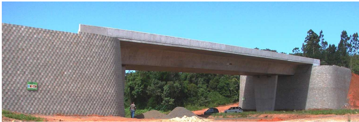
Construcción de un acceso transversal a la autopista.
