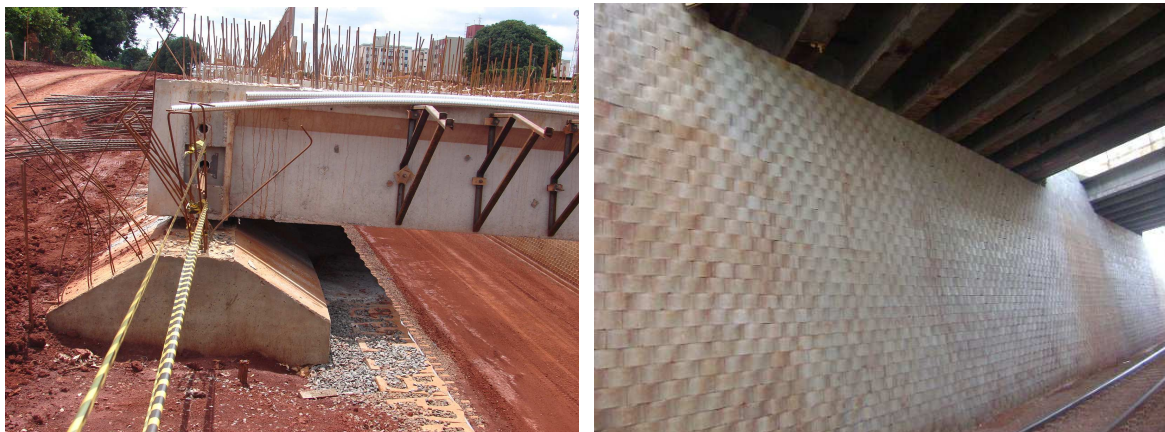
Detalle de la vigueta de apoyo sobre el muro en suelo reforzado y vista frontal del encuentro debajo del viaducto
