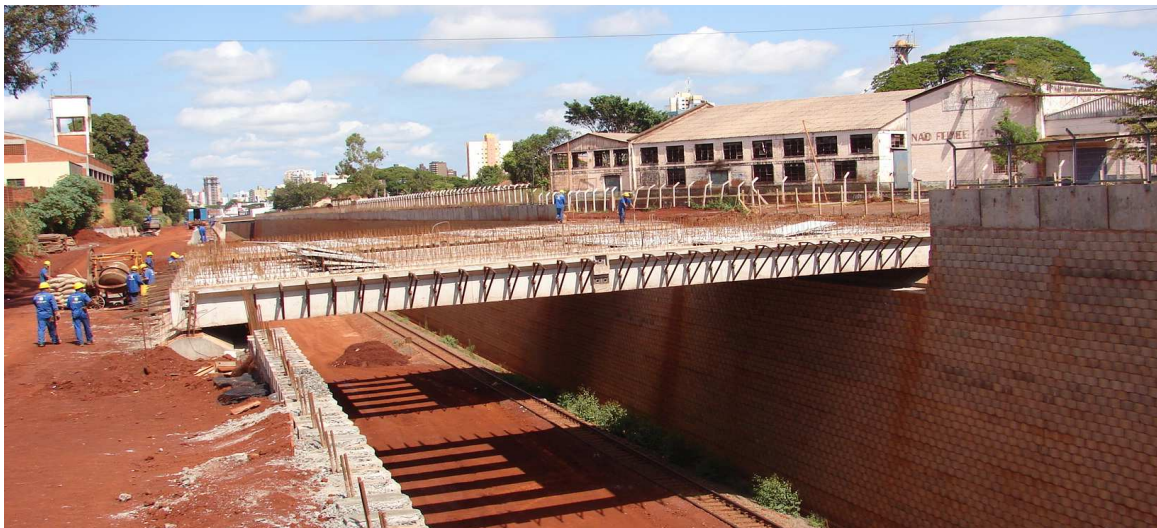
Colocación de las vigas longitudinales pre-moldeadas.
