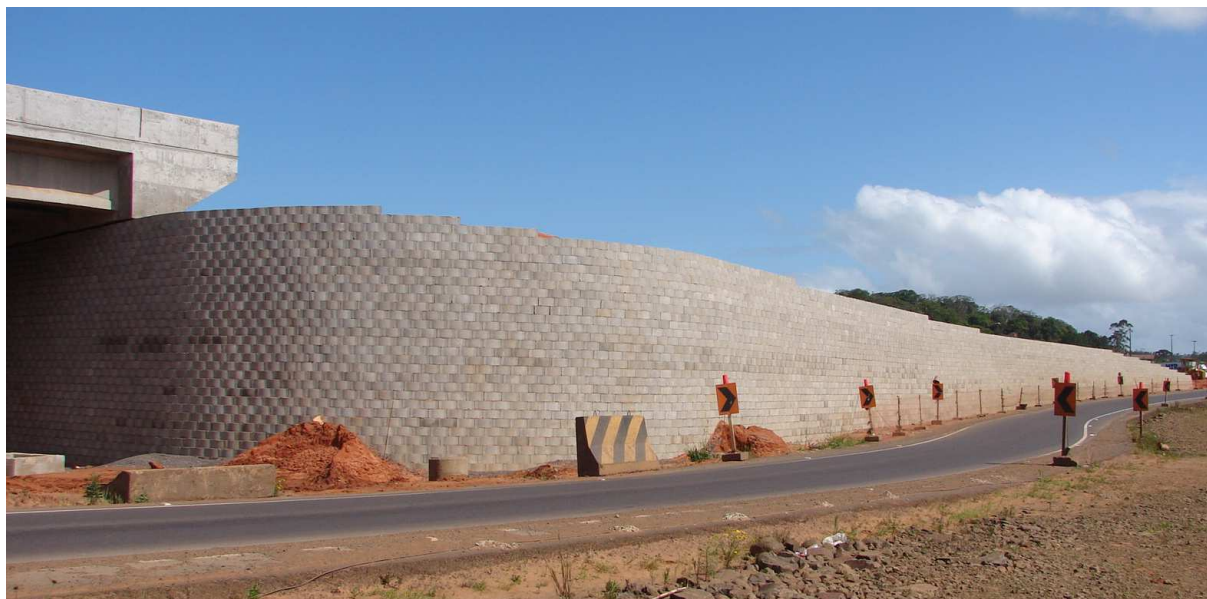
Construcción de un estribo en un pasaje inferior a la autopista.
