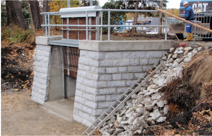
Abb. 3 Neu erbautes Einlassbauwerk
