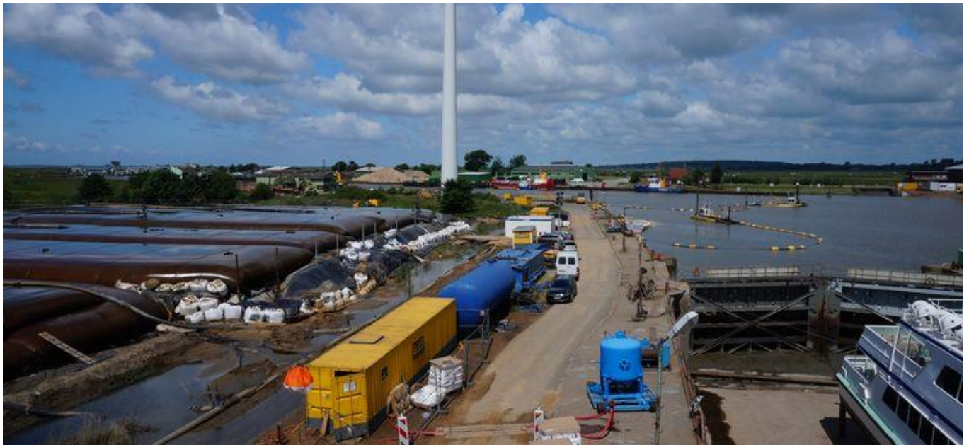
Figure 4 : Vue sur le chantier, dragage, floculation, remplissage des tubes
