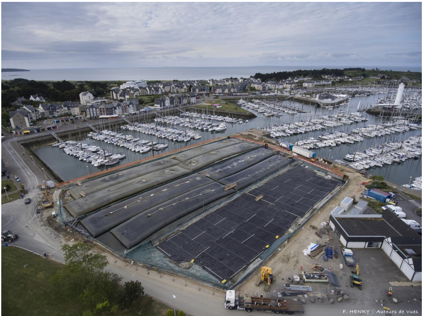
Figure 10 : Vue sur le port Crouesty en cours de dragage et la plate-forme d'essorage au moyen de tubes filtrants géosynthétiques. On distingue les tubes en cours d'essorage (arrière-plan), de remplissage (au milieu) et prêts à être remplis (premier plan).
