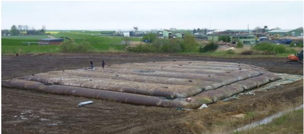
Figure 6 : Vue sur la plate-forme d'essorage six mois après la fin de la 1 ère phase du chantier
