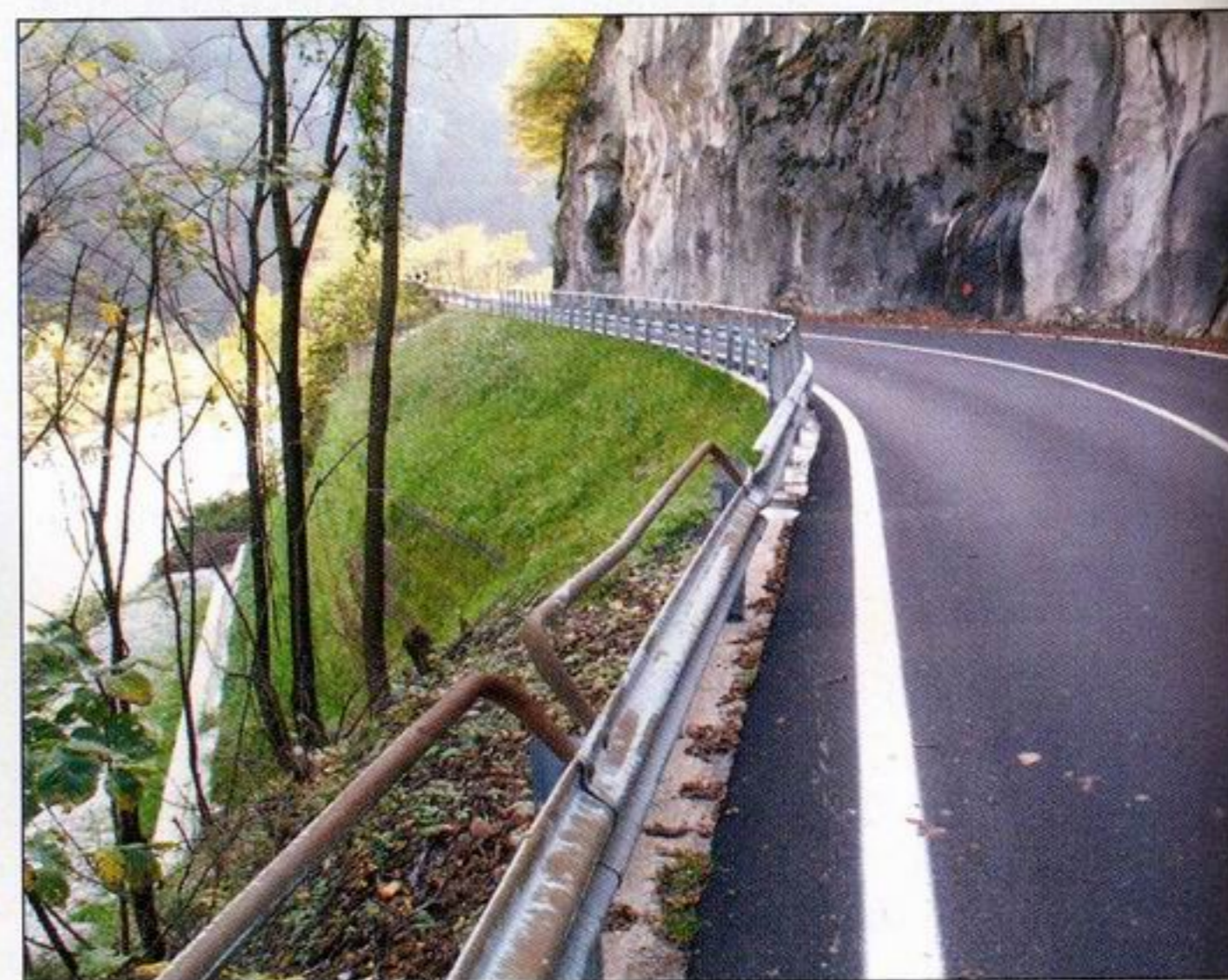
La sede stradale ripristinata
