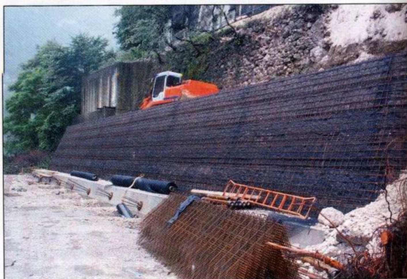
Il cordolo di fondazione tirantato e la terra rinforzata in fase di esecuzione
