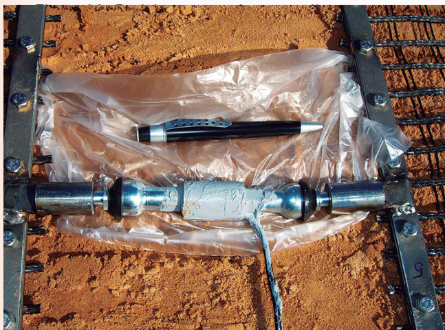
Figura 11. Posicionamento das geogrelhas instrumentadas na obra.
