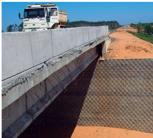
Figura 14. Detalhe do posicionamento de um caminhão carregado no apoio do viaduto para as medidas das células de carga.
