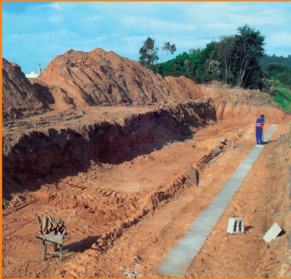
Figura 4. Fase inicial da construção do muro com a preparação da fundação.
