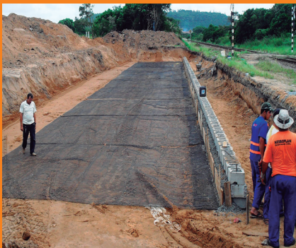
Figura 5. Colocação das geogrelhas, blocos e brita.
