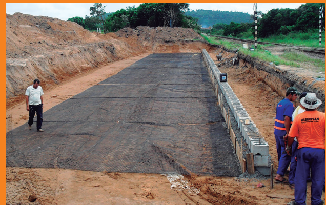
Figura 6. Compactação do aterro arenoso com rolo vibratório.
