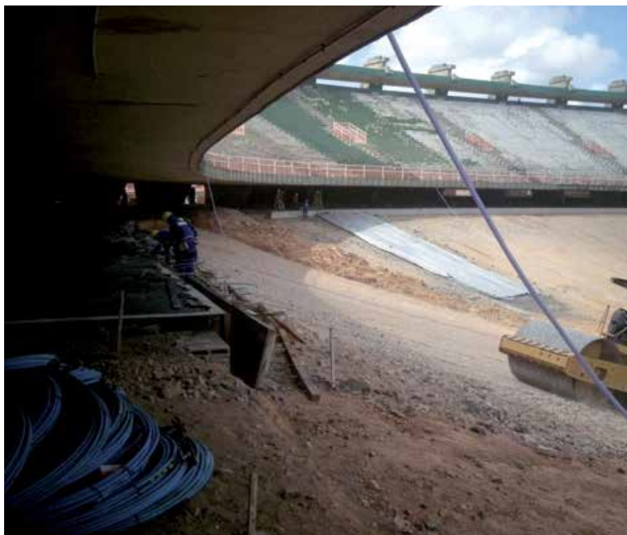
Em Fortaleza (CE), a obra do estádio Governador Plácido Castelo, a Arena Castelão, apostou em muros de solo reforçado com geogrelhas Fortrac PVA
