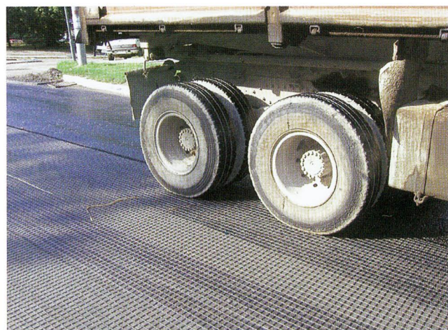
Bild 4. Befahren von HaTelit C 40/17 mit Mischgut LKW
